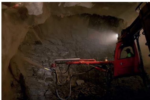
Vår sprøyter i aksjon på stoff i Skarvbergtunnelen.
