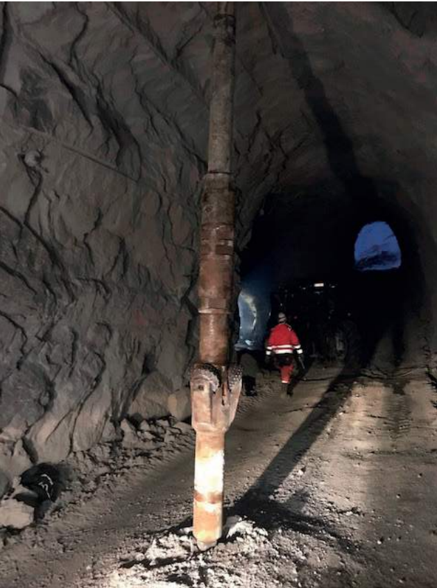
Montering av rømmekrone Ø 440mm – Smisto kraftverk. Innsendt av Harald Solheim.
