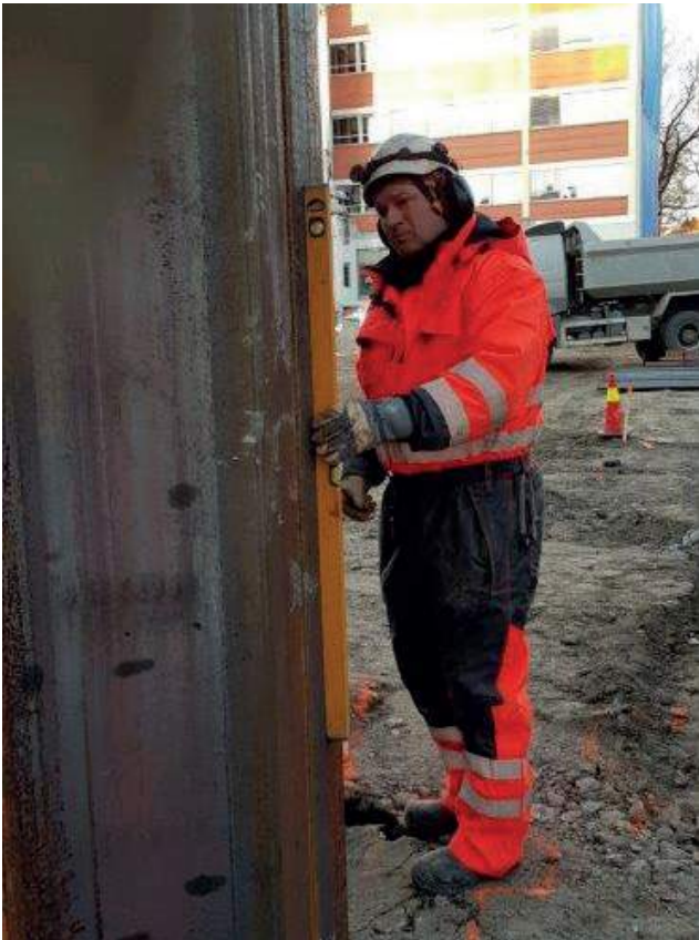
Sjekk ved Pilarski.
