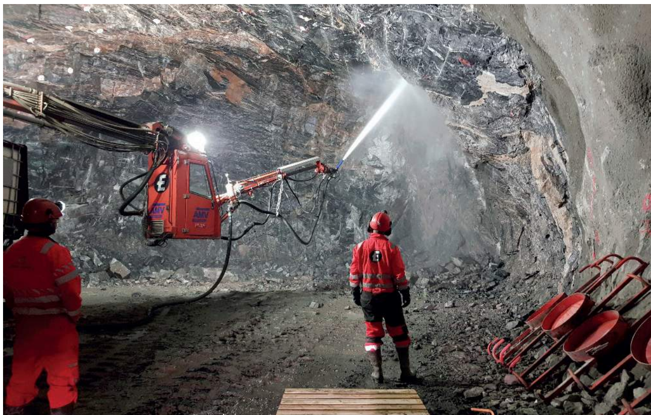
Avd.leder Hetlebakke inspiserer vasking før sprøyting på Nordøyvegen.
