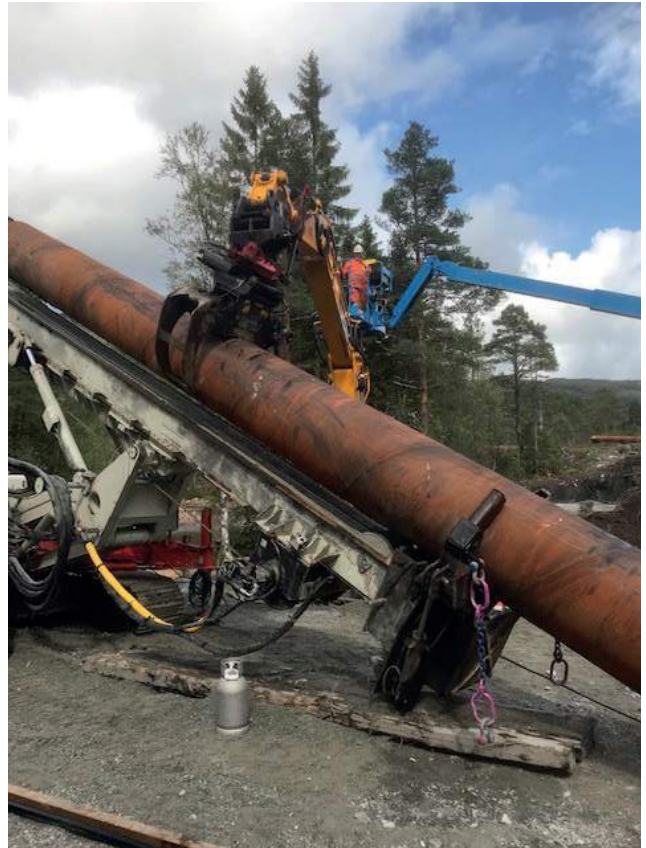
Rørsetting på Løkkebø kraftverk. Innsendt av Harald Solheim.
