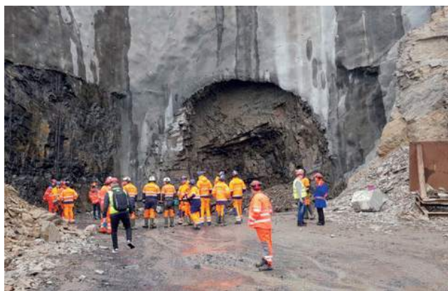
Påhugget til tunnelen ferdig sikret med sprøytebetong.
